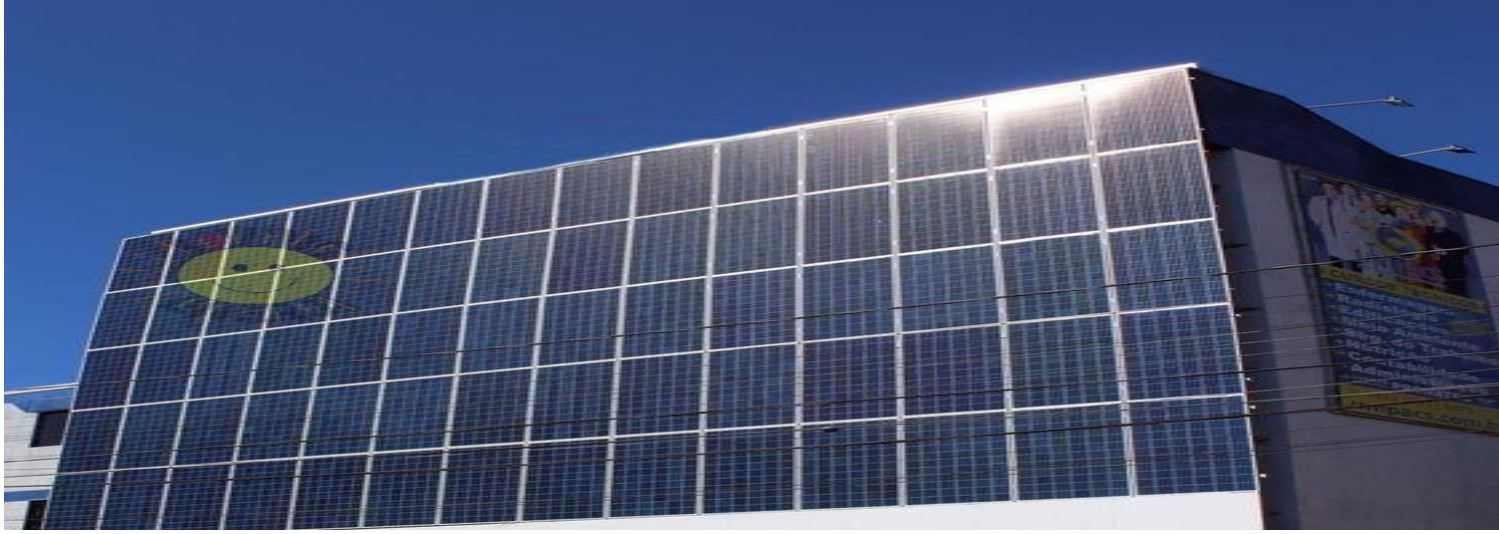
Bina cephe güneş enerjisi uygulaması
