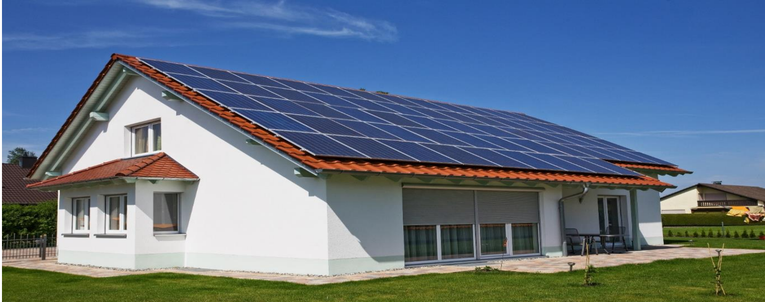
Çatı güneş enerjisi uygulaması
